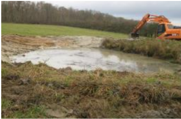
Travaux sur une mare.
