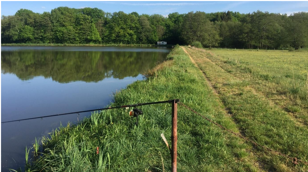
Vue de la digue
