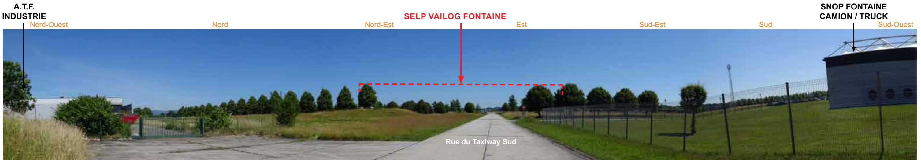
6 - VUE DEPUIS LA RUE DU TAXIWAY SUD, VERS LE NORD-EST
